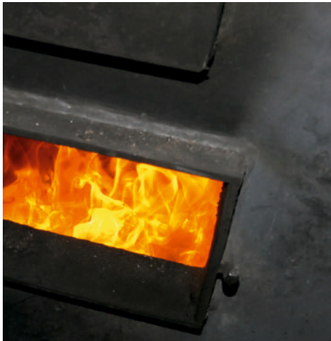
Miasto w 2020 r. przeznaczy 420 tys. zł. na dofinansowania do wymiany kotłów w budynkach mieszkalnych.
