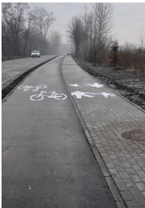
Nowy chodnik i ścieżka rowerowa mają ponad pół kilometra. Koszt tej inwestycji wyniósł ponad 600 tys. zł. Fot. UM
