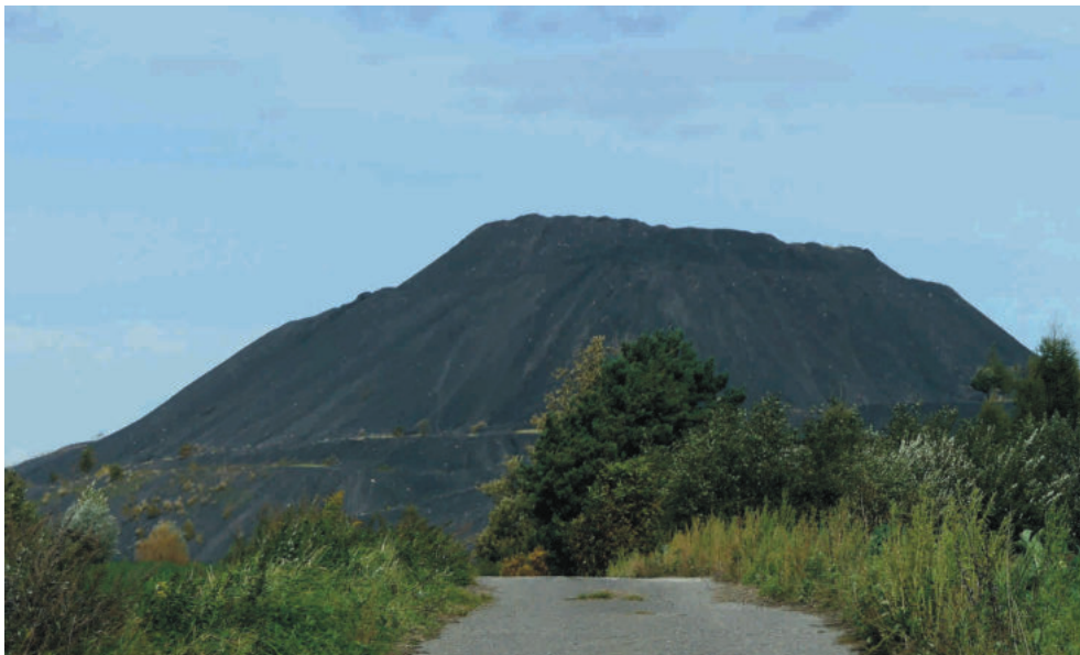
Hałda zostanie pokryta warstwą izolacyjną, dzięki czemu do atmosfery będzie emitowanych mniej gazów pożarowych. Fot. UM
