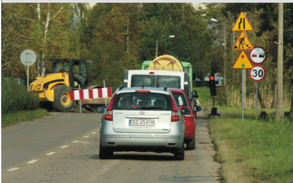
Modernizacja ul. Traugutta będzie kosztować 3,6 mln zł. Fot. UM
