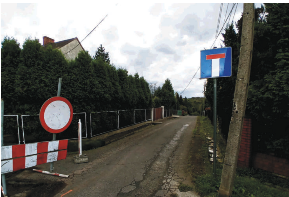
Ul. Żużłowa będzie remontowana do 2022 r. Fot. UM
