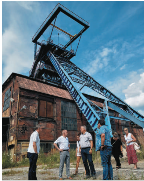
Wizja lokalna zespołu miała uświadomić w jakim stanie są pokopalniane budynki. Fot. UM
