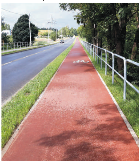
Przebudowa ul. Traugutta zwiększy przepustowość ruchu i podwyższy standardy. Fot. Starostwo Powiatowe
