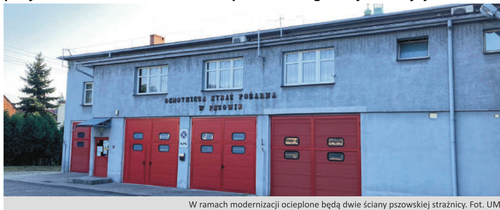
W ramach modernizacji ocieplone będą dwie ściany pszowskiej strażnicy. Fot. UM
